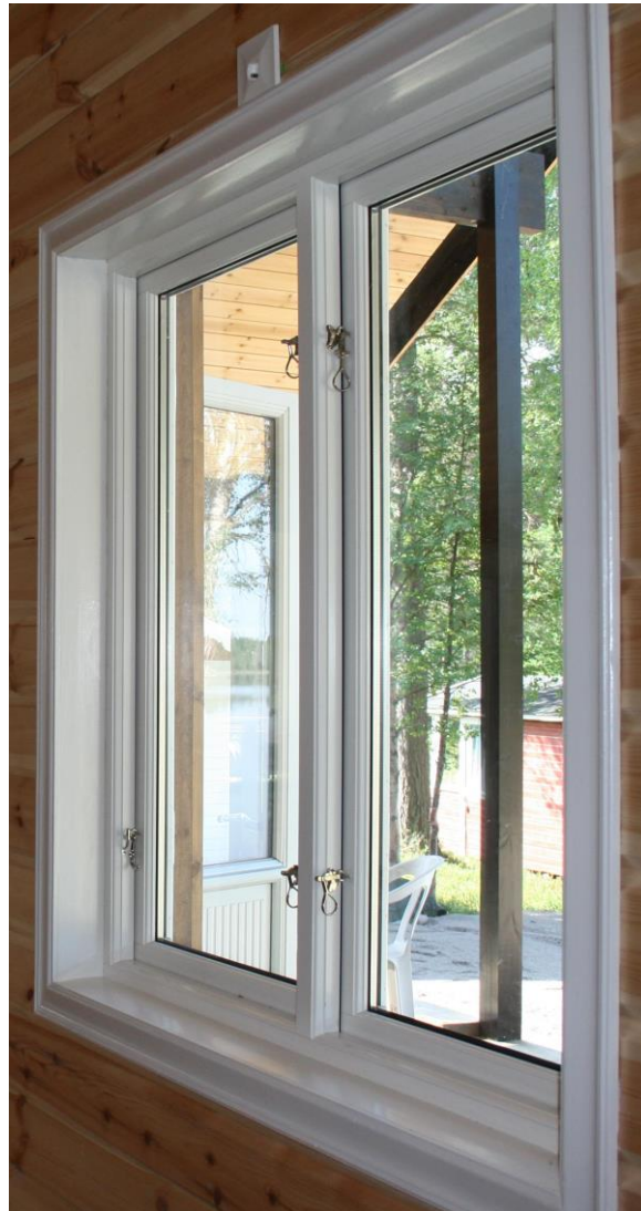
Bild 11 Invändig fönstersmyg och foderlist
