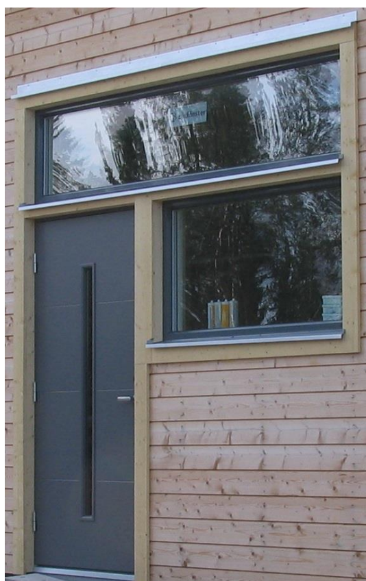
Infräst i ytterpanel
