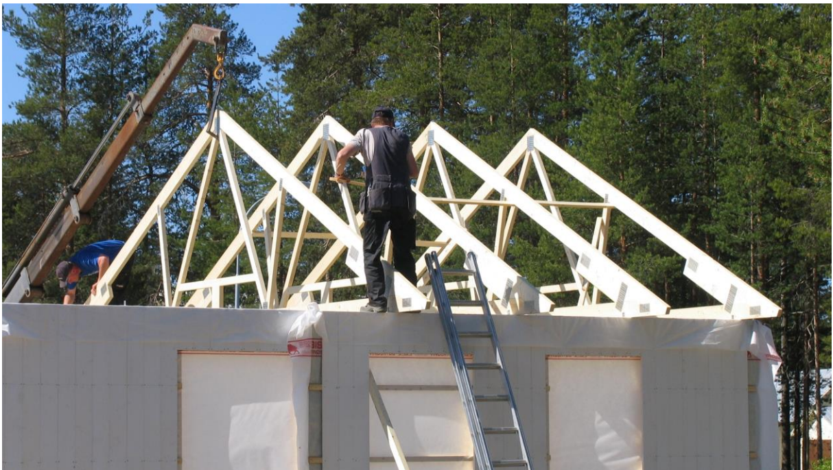
Bild 2 Strävning av takstolar
