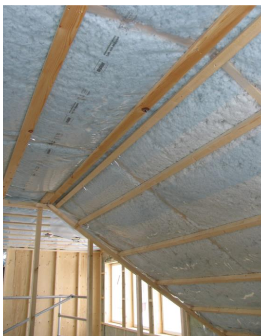
Bild 4 Montering av glesspikning vid lösull
