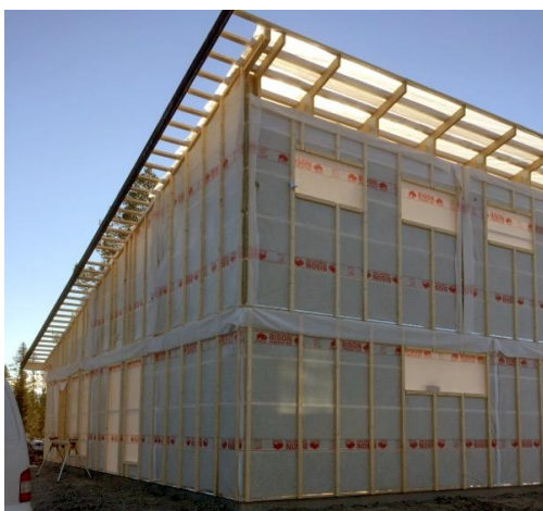
Bild 3 Montering av takläkt
